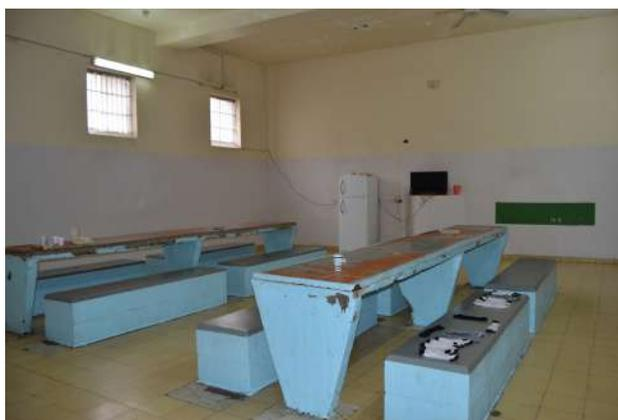
La iluminación natural se obtiene de dos ventanales, mientras que la artificial proviene de cuatro plafones de luminaria doble colocados en las paredes. Ambas resultan insuficientes en relación a la superficie a iluminar.
